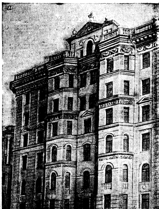
Рис. 125. Лепные работы на фасаде и внутри здания.
