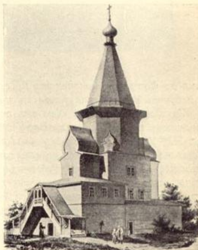
Рис. № 319. Церковь Шеговарского прихода. По В. Суслову.
