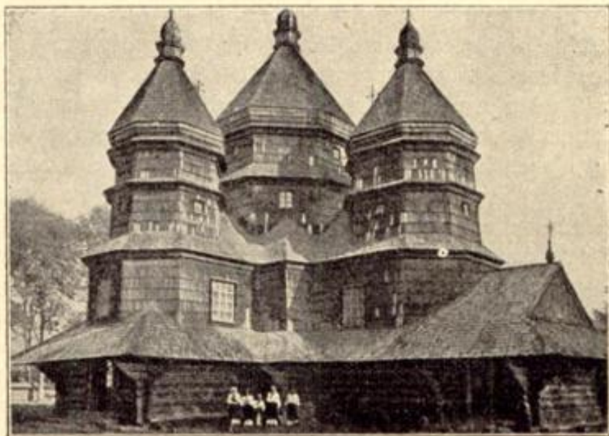
Рис. № 527. Церковь въ селѣ Князеворѣ. По В. Щербакивскому.
