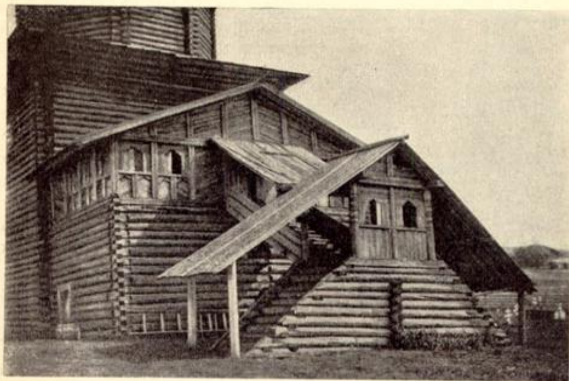
Рис. № 310 а. Крыльцо церкви въ Почѣ. Фот. И. Билибина.
