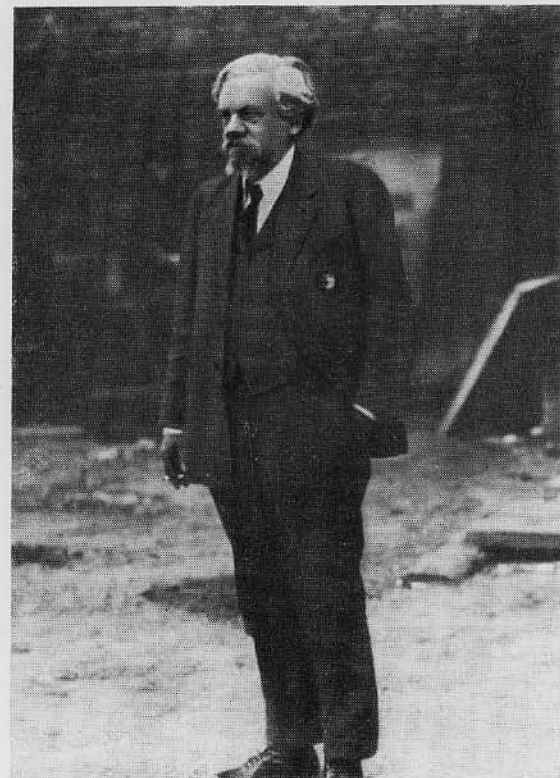
С. А. Чаплыгин на строительстве ЦАГИ.
