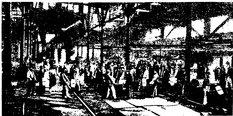
Фиг. 63. Отливка очень крупного слитка (до 1 000 тиглей вместе) из тигельной стали на зав. Круппа.
