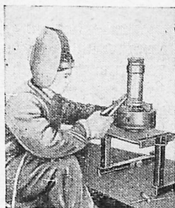
Рис. 6-2. Манипулятор с самоцентрирующим патроном. Сварка корпуса насоса Н-1-С.
