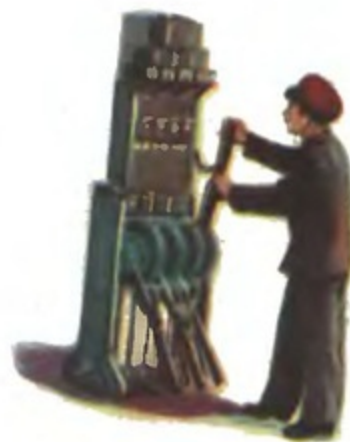
Дежурный по станции у аппарата полуавтоматической блокировки открывает семафор.
