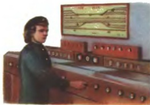
Сигналист у аппарата электрической централизации.
