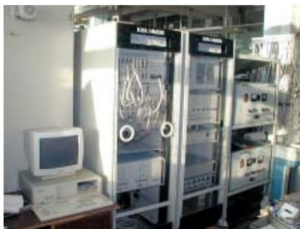
АСКС-2400 — автоматизированная система контроля сопротивлений, используемая при проверках схем подключений и электрического сопротивления изоляции. Эксплуатируется с 1992 г.
