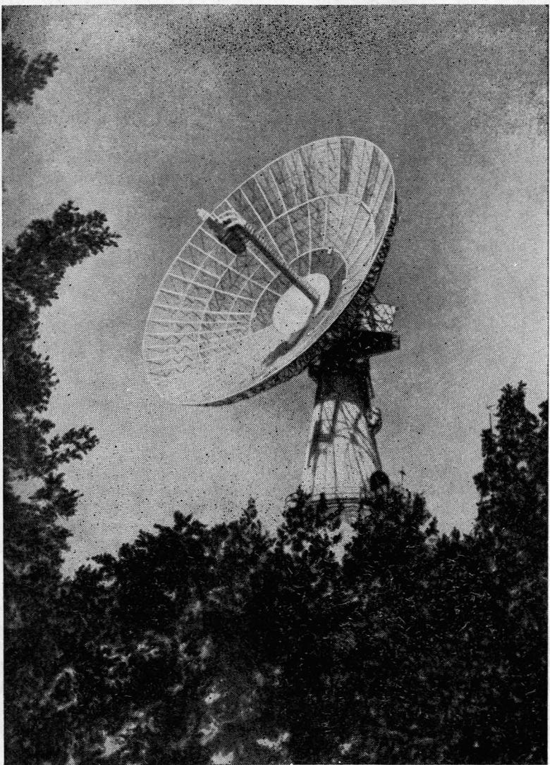
Рис. 31. Антенна диаметром 25,5 м (Майлстоун), при помощи которой впервые была осуществлена радиолокация Венеры. (Фотография получена из лаборатории им. Линкольна Массачусетского технологического института.)
