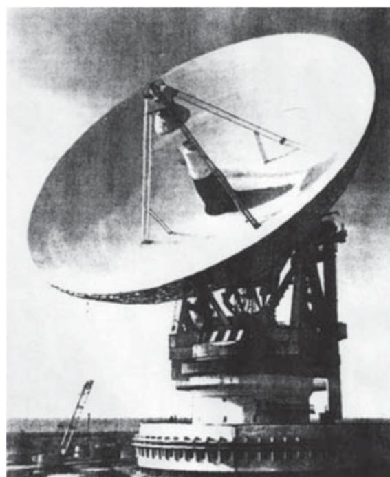
Рис. 2. Приемо-передающая полноповоротная антенна диаметром 70 м Центра дальней космической связи в Крыму, используемая для планетного радиолокатора СССР с 1980 г.
