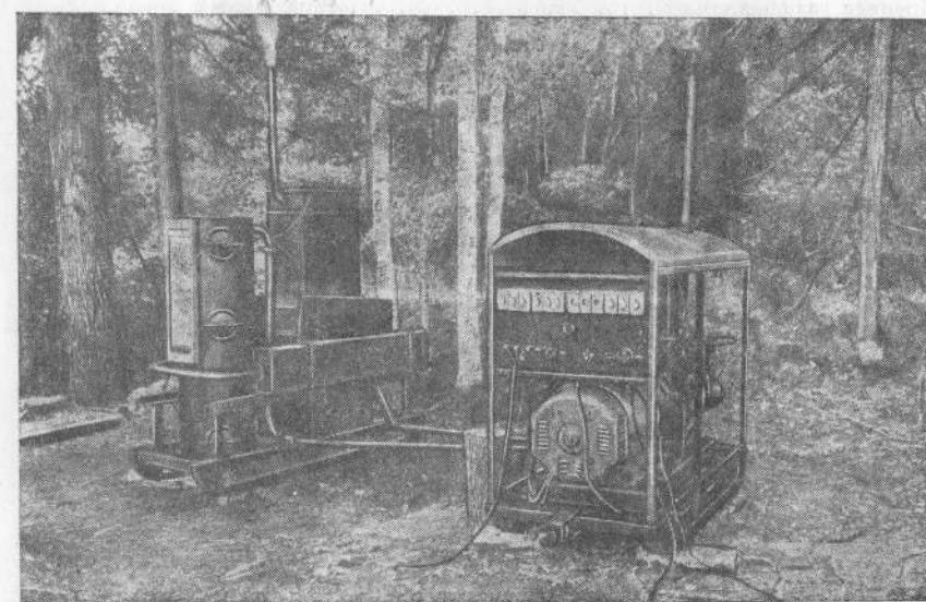
Рис. 4. Общий вид передвижной электростанции ПЭСГ-12-200 с газогенераторной установкой ЦНИИМЭ-18
