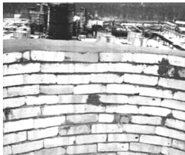
Рис. 2.94. Дефекты дымовой трубы установки Л24/7
