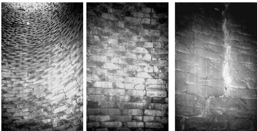
Рис. 2.96. Вертикальные трещины с раскрытием шва
