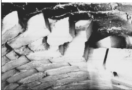
Рис. 2.100. Разрушение футеровки
