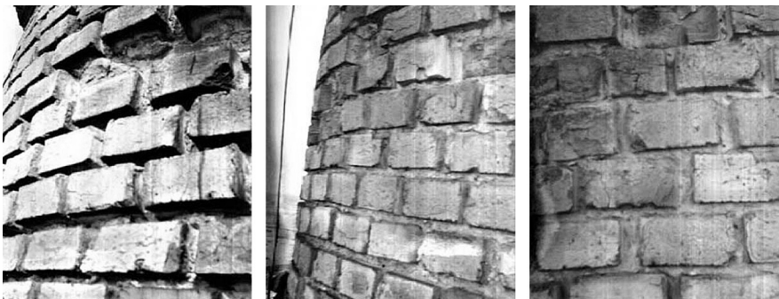
Рис. 2.97. Выкрашивание кирпича
