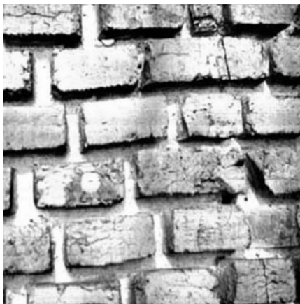
Рис. 2.95. Выветривание раствора кирпичной кладки
